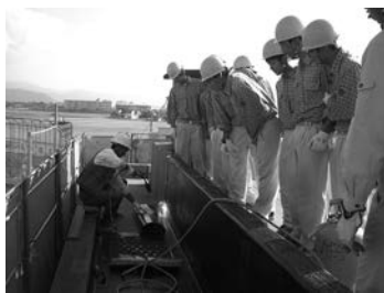
屋上防水改修の見学
