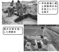
図1：実験池の施工
