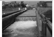
図1：落差による水路ネットワークの分断
